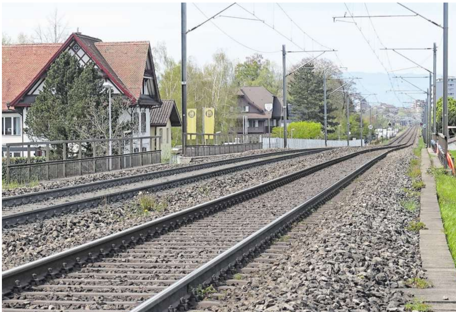
Blick vom alten Wärterhaus bei den Stierenstallungen Richtung Cham. Gut sichtbar die Rampe, welche kurz nach dem Lorzenübergang auf das Höhenniveau der 1990 aufgehobenen Schleife und des Bahnhofes Zug zu steigen beginnt.
