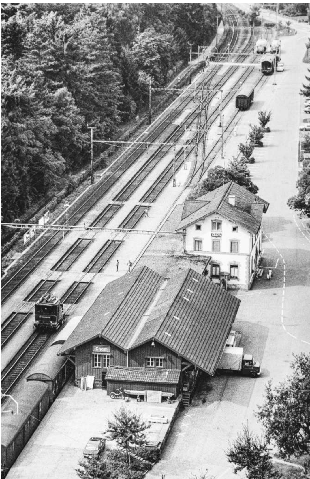
Die Aufnahme von 1983 vom Chamer Kirchenturm aus zeigt die Topologie des Bahnhofes, welche seit 1910 unverändert geblieben war. Der «Hausperron» beim Stationsgebäude dient dem Güterverkehr, Richtung Rotkreuz sind drei Auszugsgleise für den Güterumschlag, welche von den Zugspassagieren passiert werden mussten! Der «Hausperron» war Bestandteil der Bahnhofserweiterung von 1894 und der Grund für die «Niederlegung» des ersten Stationsgebäudes, das im Weg stand. Bild: Thomas Gretener, Cham
