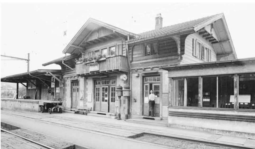
Das erste Stationsgebäude von Cham aus dem Jahre 1864 steht seit 1900 in Bäch im Kanton Schwyz (zwischen Richterswil und Freienbach an der Linie Zürich-Chur). Die Aufnahme von 1976 zeigt den Bahnhof noch im vollen Betrieb. Der Güterschuppen links und der Anbau für das Stellwerk rechts kamen erst in Bäch hinzu. Bild: ETH-Bildarchiv, Com_Ex-BA01-0373-0002-0008
