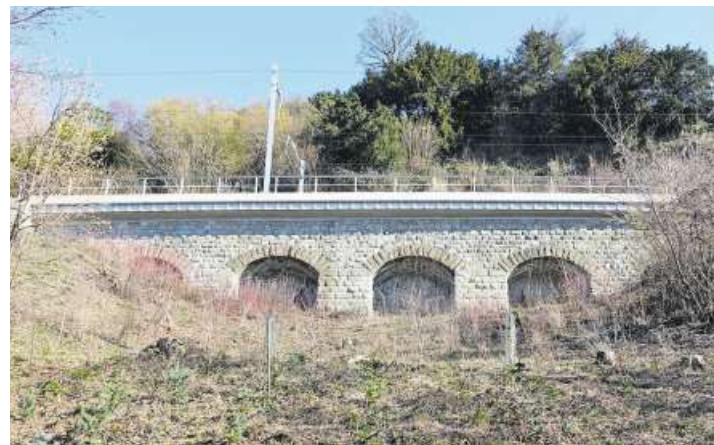
So sieht die Stelle des Dammrutsches heute aus. 1911 erstellte die SBB ein solid fundiertes Lehnenviadukt, das bis heute Bestand hat und beim Doppelspur-Ausbau weiter verwendet werden konnte. Die «Wiederherstellung des Bahnkörpers» kostete 40'207 Franken.
