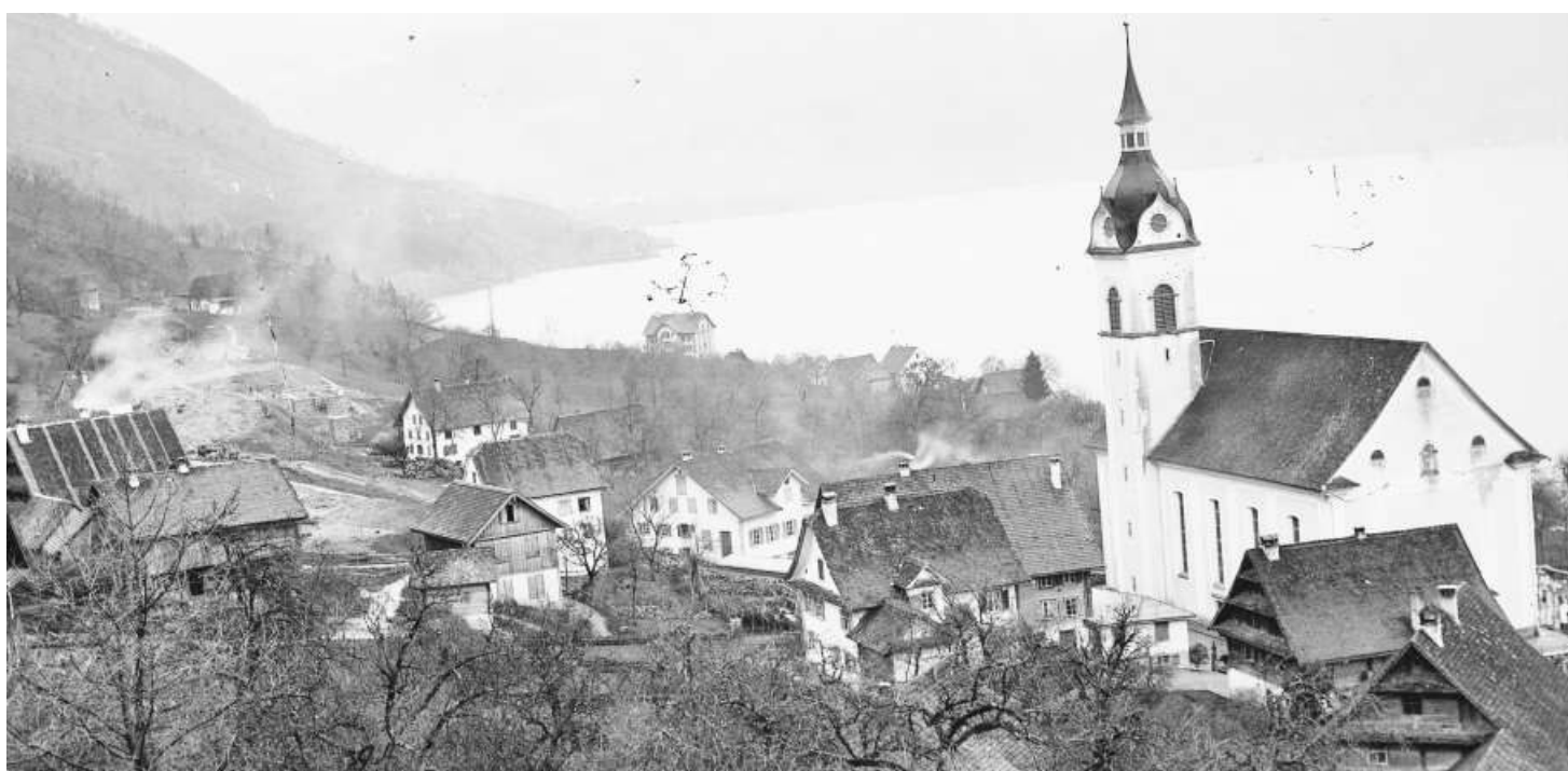
Ende 1895 konnte endlich mit dem Bau der Bahnhofsanlage begonnen werden. Im Hintergrund wird an der Erstellung des Planums gearbeitet, wie die horizontal ohne Gefälle ausgerichtete Fläche der Bahnhofsanlage bezeichnet wurde.
