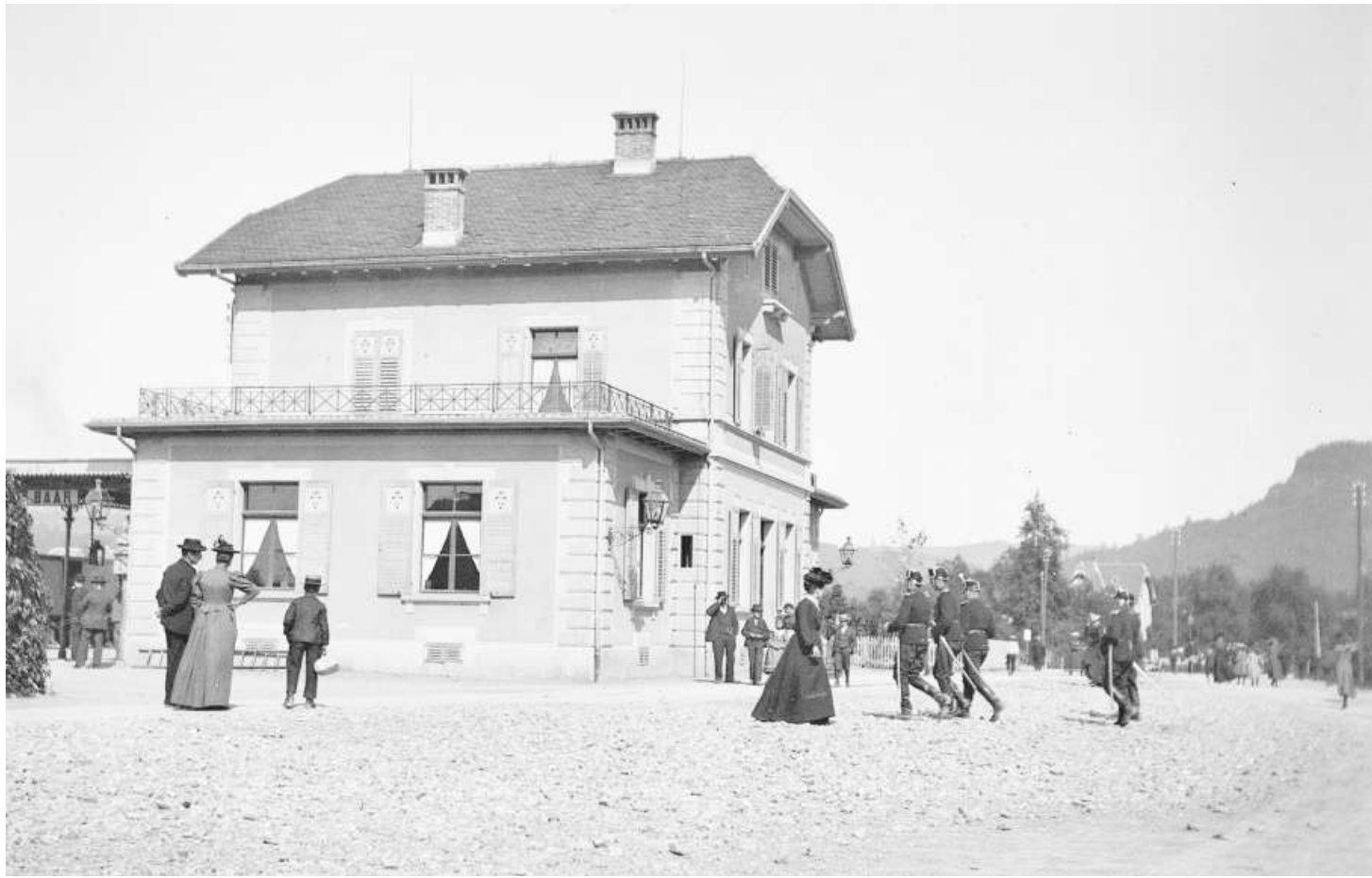
Das «Aufnahmsgebäude» und der östliche Teil der Bahnhofsanlage in Baar um 1904. Auch in Baar stand die Anlage auf einer Insel, die nicht sichtbare Böschung Richtung Süden ist längst verschwunden, der Neumühlenbesitzer Haab füllte sie 1907 auf und errichtete ein Trottoir.
