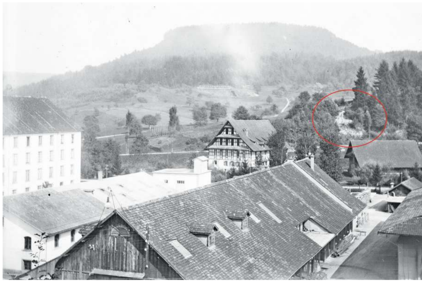
1860 wurde in Baar bereits fleissig an der Ost-West-Bahn gebaut. Der rot markierte Einschnitt im Hang wirkt auf dieser Aufnahme vom Spinnereigelände aus 1907 immer noch frisch, er ist heute eingewachsen, aber immer noch sichtbar. Bild: Staatsarchiv Zug
