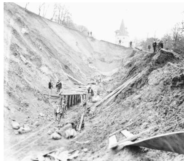
Blickrichtung Nordportal Stadttunnel – der Richtstollen ist begonnen, im Hintergrund der Kapuzinerturm. Bild: Fotosammlung Bibliothek Zug
