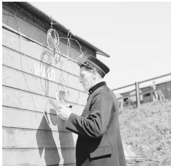
Die neue Verladerrampe war fix, andere Installationen hingegen eher provisorisch.
