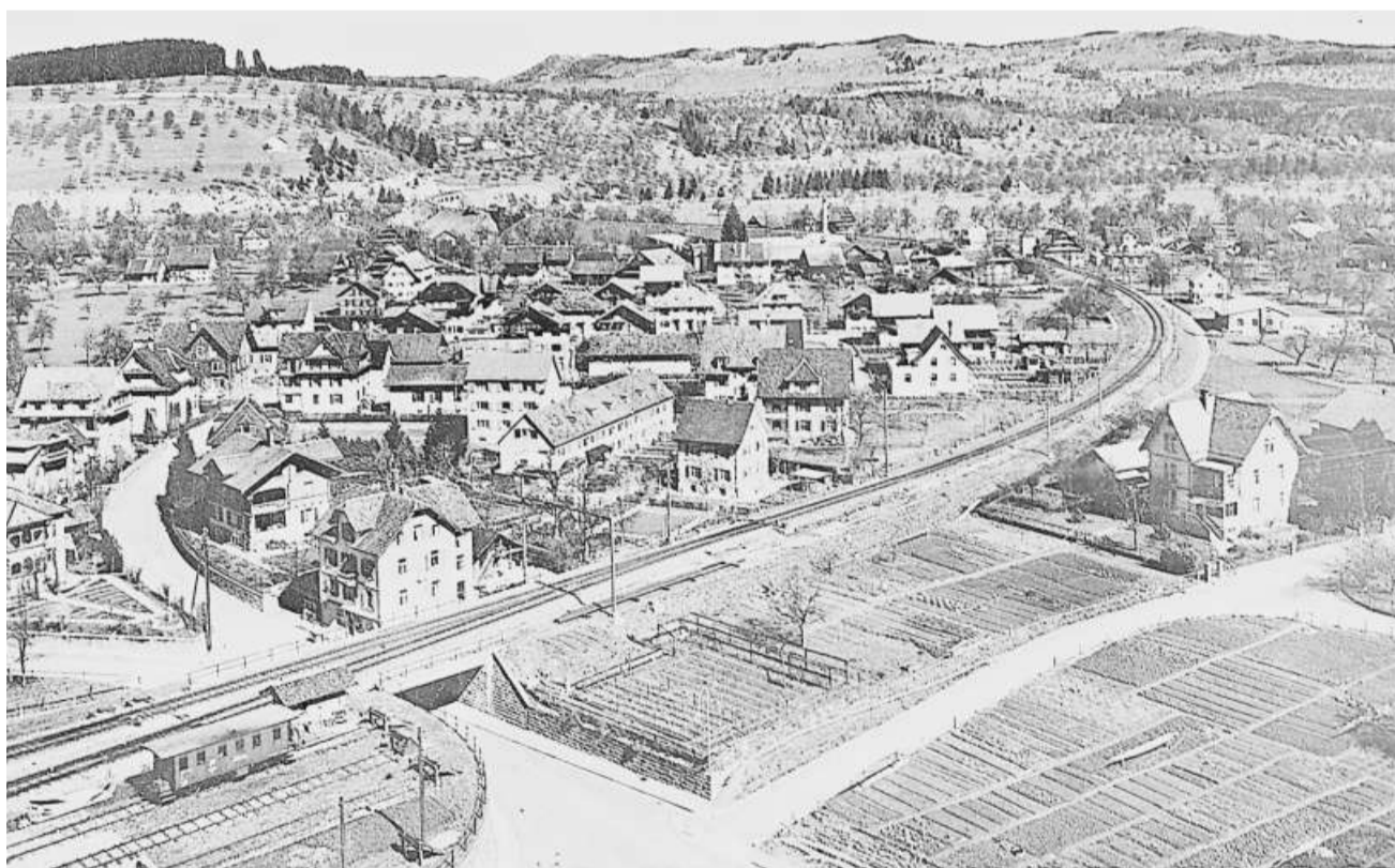
Diese undatierte Aufnahme (möglicherweise um 1930 vom Silo Neumühle aus gemacht) zeigt den Streckenverlauf in Baar Richtung Tunnelportal Littli. Links oben die Materialgrube Jöchler.
