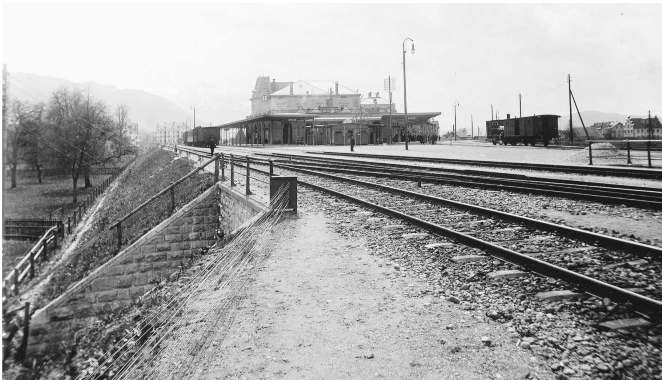
Die ungewöhnliche Perspektive macht die Insellage des Bahnhofs Zug deutlich. Im Vordergrund die Drähte zu den Weichen – Standort Fotograf beim Stellwerk.
